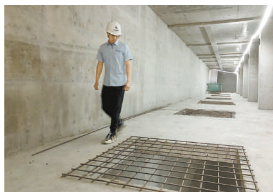
岳各庄桥区调蓄池地下二层,工作人员在巡检。
